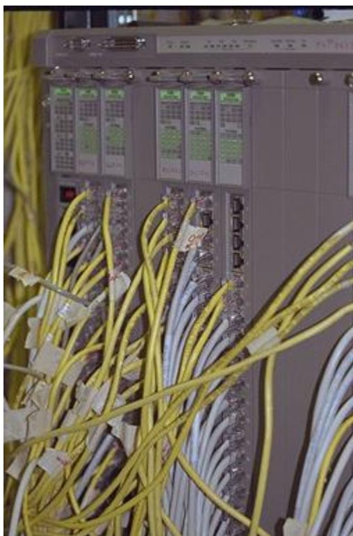
Slika 8.11: Koncentrator (hub) za TP Ethernet sa uključenim TP kablovima.
