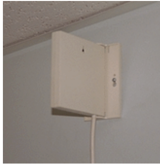
Slika 3.4: instalacija za wireless mrežu.
