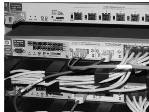
Međusobno stackirani preklopnici (plava žica, bakar) te optički spoj na uplink (crvena žica, optika)
